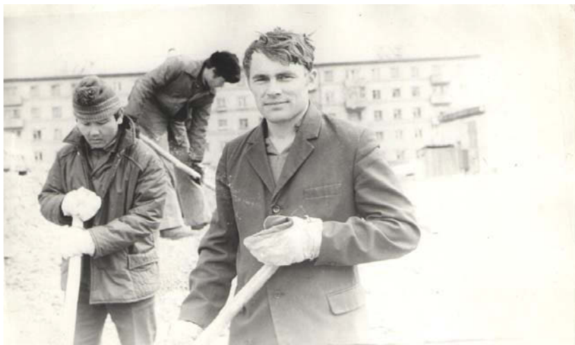
Стройотрядовцы готовят фундамент для общежитий БГПИ им. Д. Банзарова по улице Сухэ-Батора (1974 г.)
